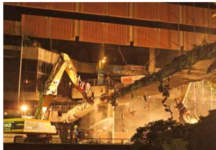
Abbildung 4: Abriss der Fußgängerbrücke zum Eingang der alten Bibliothek (Foto: Sebastian Bender)
