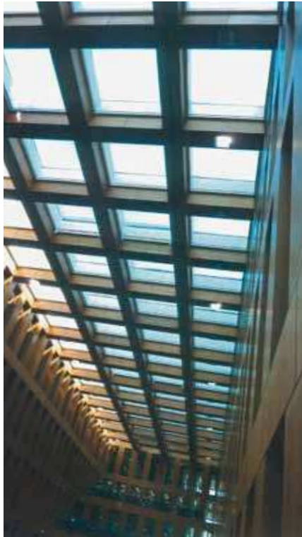
Abbildung 11: Lesecke Abbildung 12: Glasdecke über dem Großen Lesesaal Abbildung 13: Detail Glasdecke Abbildung 14: Sonderlesesaal
