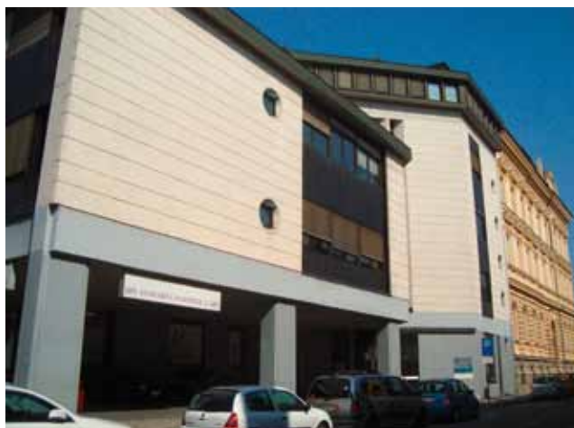
Abbildung 1: UB Maribor Außenansicht
