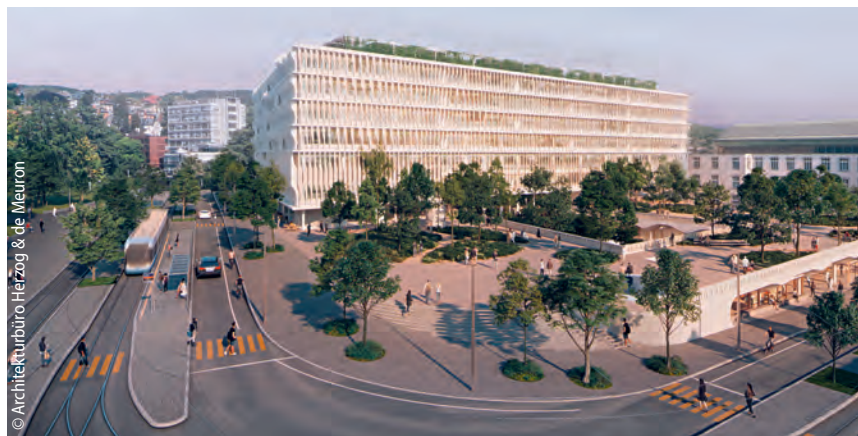
Das Forum UZH, das voraussichtlich ab 2029 eine neue Universitätsbibliothek beherbergen wird.
