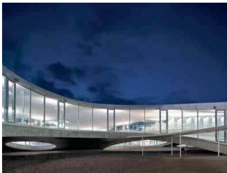
Abbildung 4: Die sanft ansteigenden Ebenen führen zum Bibliotheksbereich bei nächtlicher Beleuchtung*
