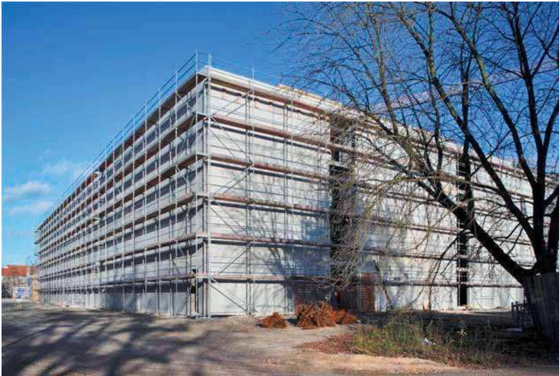
Der Magazinbau von außen ...
