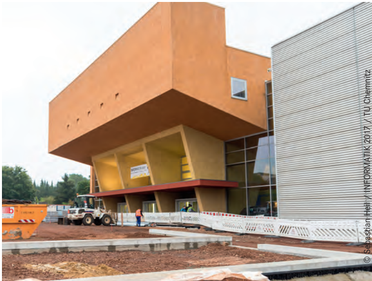
Abbildung 1: Durch Bauarbeiten eingeschränktes Tagungsgebäude an der TU Chemnitz
