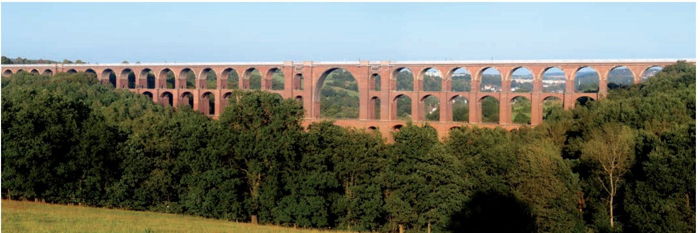
Abbildung 11: 26 Mio. Ziegel für 98 Bögen. Die Göltzschtalbrücke von 1851 15
